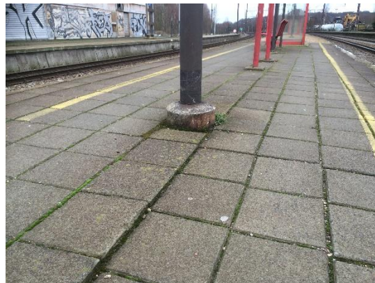
Exemple d'inégalités du sol sur une partie dallée du quai
