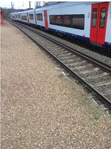
Vue d'une partie d'un bord de la voie 3
