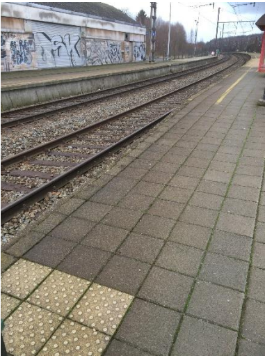
Vue de la voie 2 depuis les barrières de la sortie du passage souterrain
