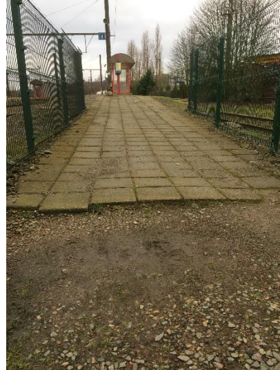
Différence de hauteur entre le sol en terre et la partie dallée entre les barrières menant à la voie 4
