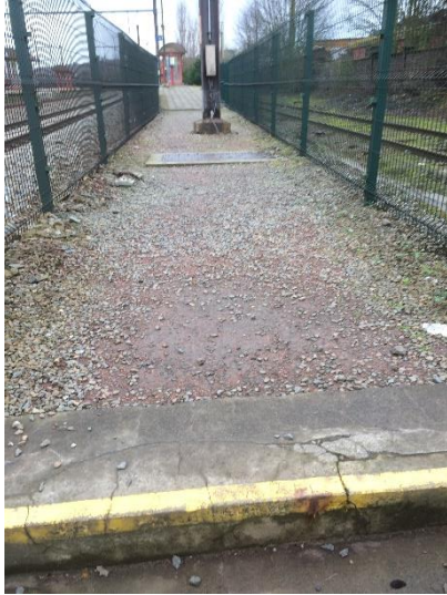
Vue depuis l'escalier vers la voie 4
