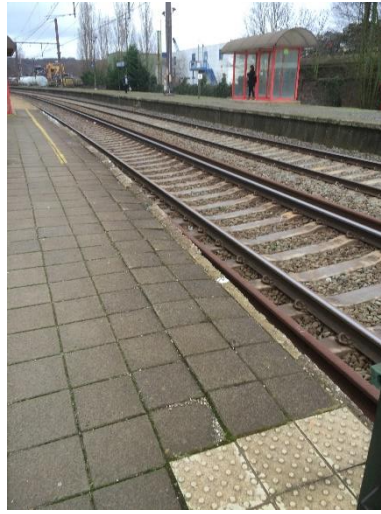
Vue de la voie 3 depuis les barrières de la sortie du passage souterrain
