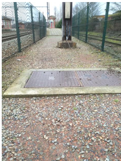
Différence de hauteur dans le sol entre les barrières menant à la voie 4
